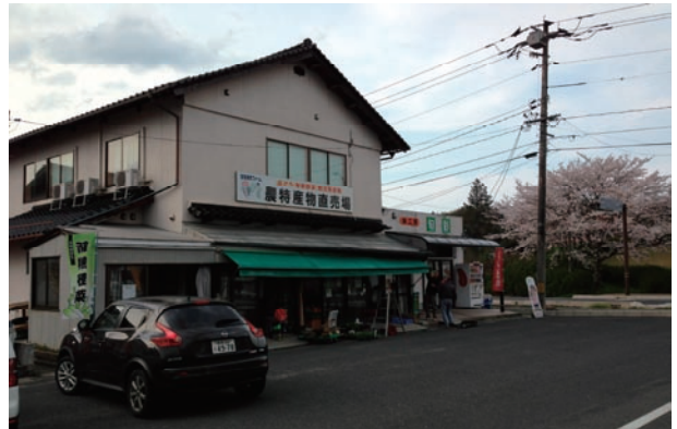
写真3 改善前の直売所Cのファサード
