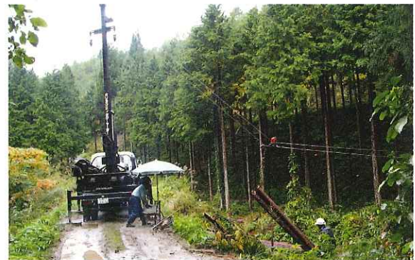
集材作業(タワーヤーダ)
