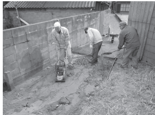
写真－2 住民による避難路補修
