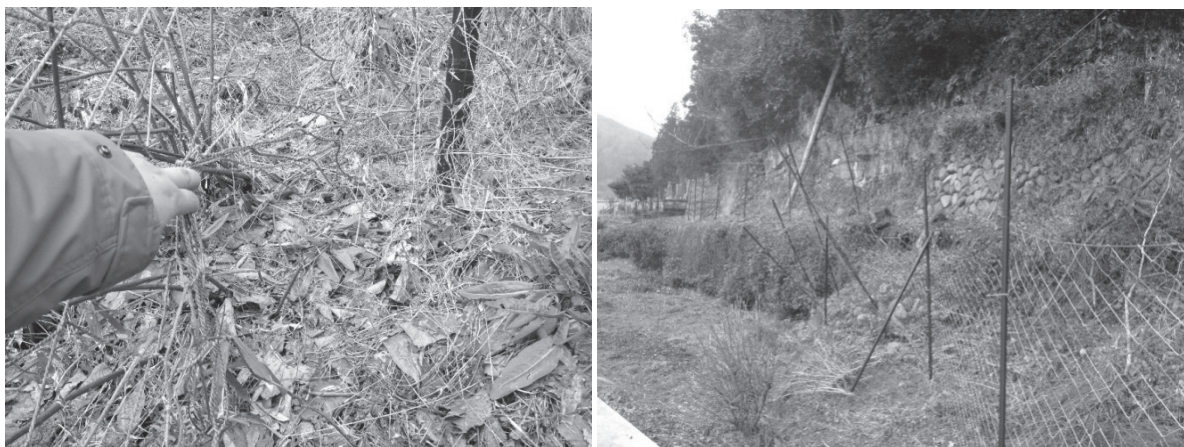
写真－1 匹見集落の山際に設置された管理が不十分な電気柵（左：ネットが破損，右：雪で支柱が倒伏）
