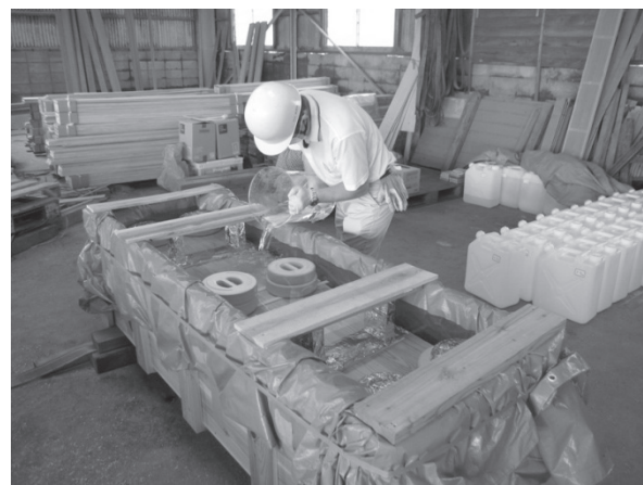
写真-4 注入槽への薬液の入れ込み
