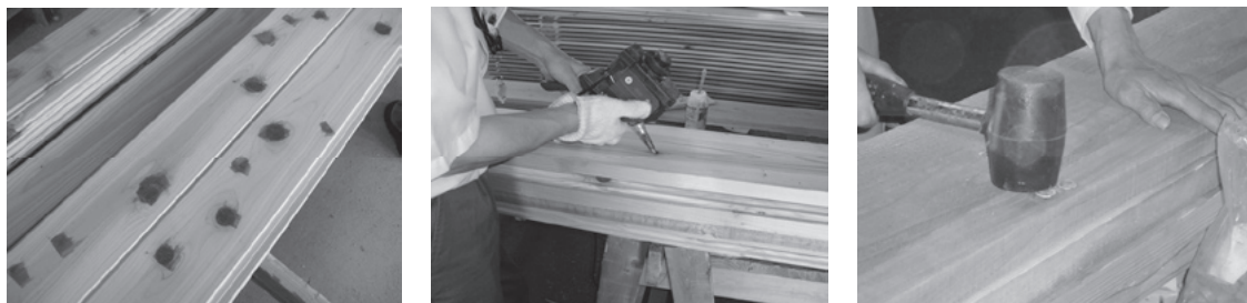
写真-1 死節・抜け節補修方法
