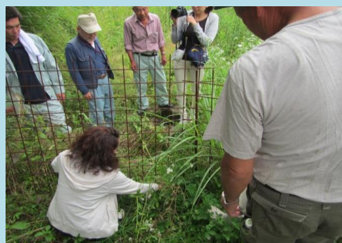
写真1 広域防護柵の点検の様子
