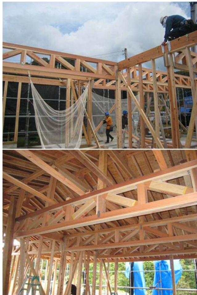
束材と上弦材、下弦材の取付けはコンパクトコーナーTANAKA-38の2個使いとし、軸力に対応させ、トラス中央部の上弦材と束材については両側から斜材が取付くため、側面にフラットプレートSDのTANAKA-33両面取付けとした。
