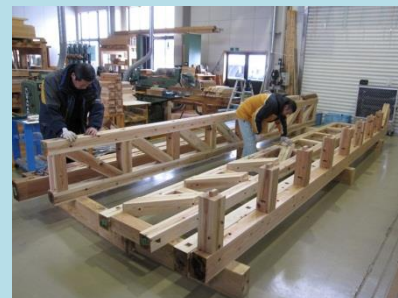
梁トラスの試作
