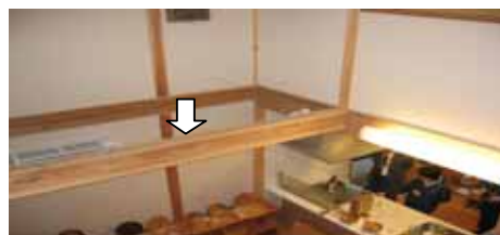
写真 - 1 梁・桁材としての利用
