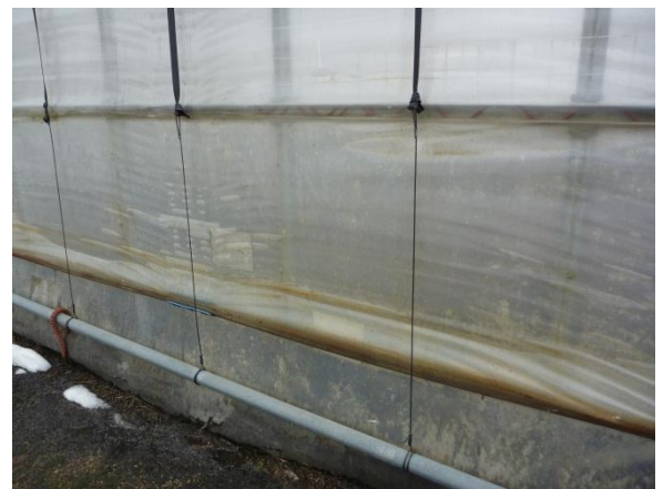
噛み切られる部分をエスター線にして、マイカ線と連結させる
