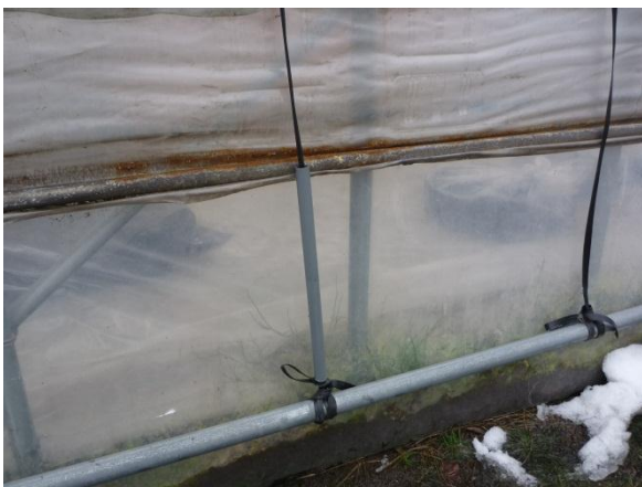
マイカ線を塩ビパイプに通して保護する
