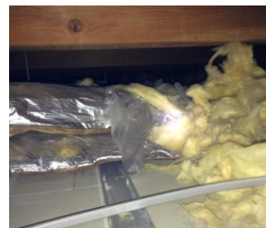
荒らされた断熱材
