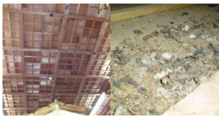
糞尿による天井の白いシミ(左) と天井裏の糞(右)
