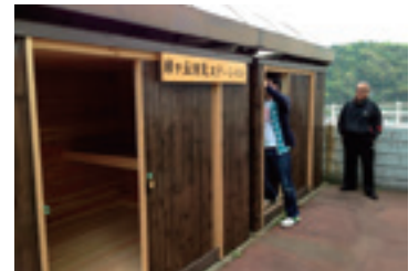
<防災備蓄倉庫の整備>
