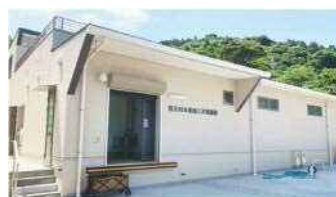
【水産物加工冷凍施設】
