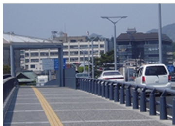
橋梁用防護柵、照明柱等の色彩を湖面の色に合わせ濃い青紫色で統一している宍道湖大橋
