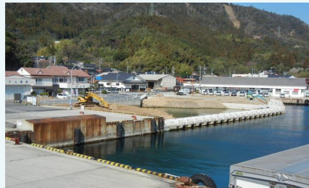
工事中: 撮影H25.2.22
