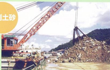
掘削土砂は、堤防背後の埋め立て材に利用しました。
