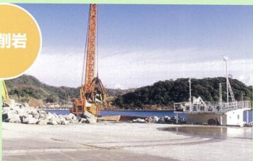
掘削岩は、港の捨石や河川の護岸材、瀬場造成における築磯魚礁として利用しました。
