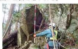
写真 5 不安定な浮石の確認
