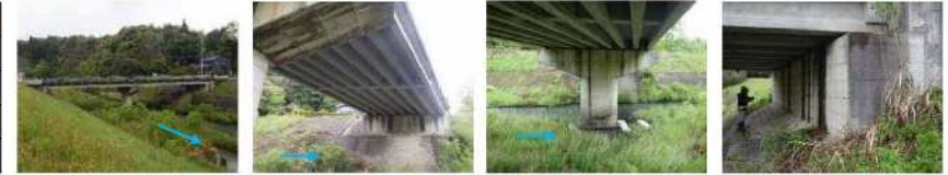
橋台・橋脚落橋防止構造: 横桁補強工(ポリマーセメントモルタル乾式吹付工)
