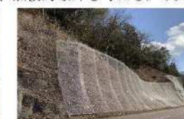
写真 3 対策完了箇所(例)
