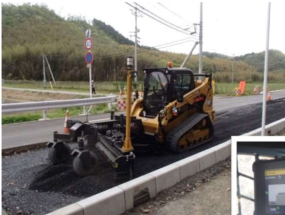
③ ICT建機による施工
