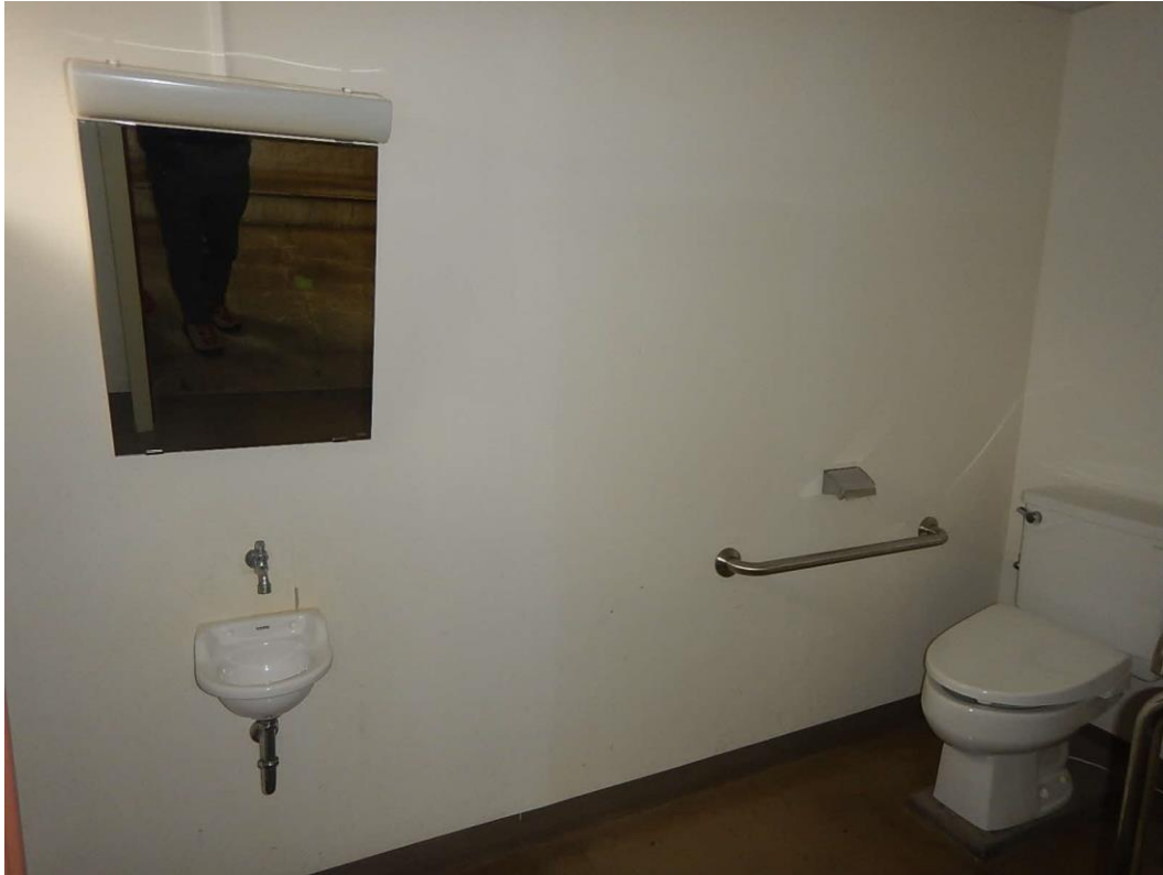
19 1階多目的トイレ
