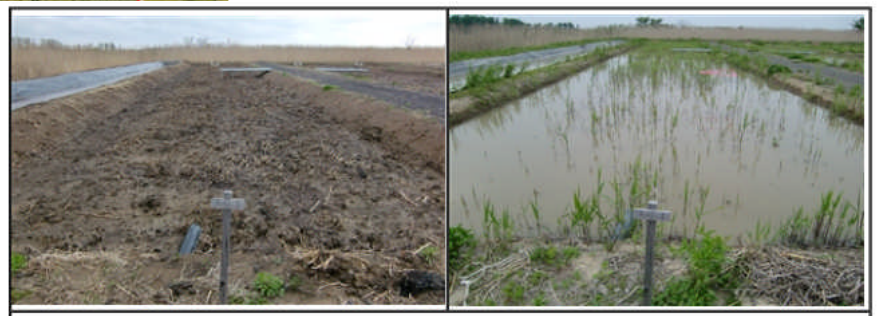
八郎湖で実施中のウェットランド浄化施設
