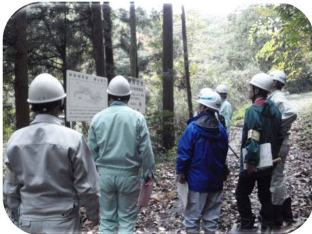
砂防えん堤点検の様子
