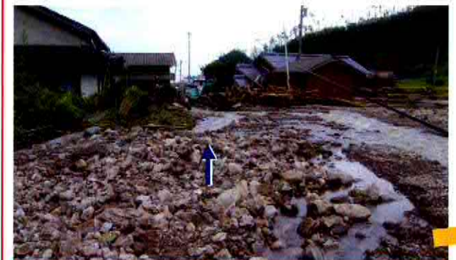
土石流による半壊1戸・床上浸水6戸・床下浸水1戸
