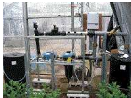
県内で使用されている養液土耕システム
