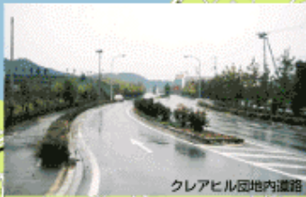
クレアヒル団地内道路
