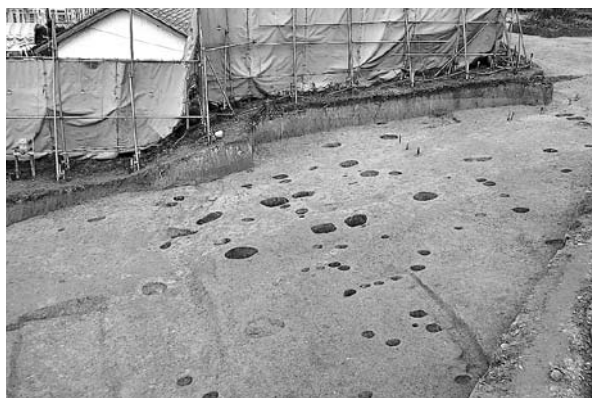
掘立柱建物跡完掘状況（東より）
