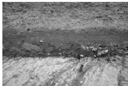
護岸裏込めの土のう積み（北より）
