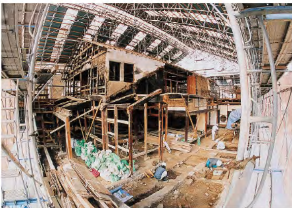
解体修理の様子
