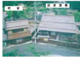
写真1. 隣接して建てられた武家屋敷と町家
