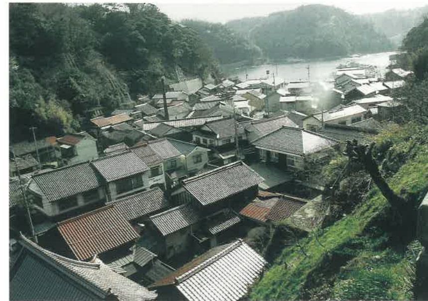
▲龍御前神社旧本殿から温泉津港方向を見下ろす
