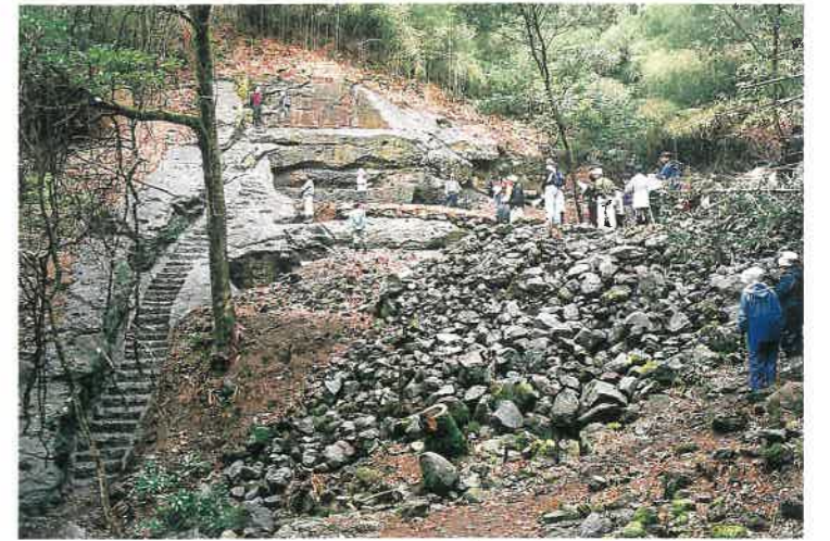
▲釜屋間歩付近岩盤加工遺構
