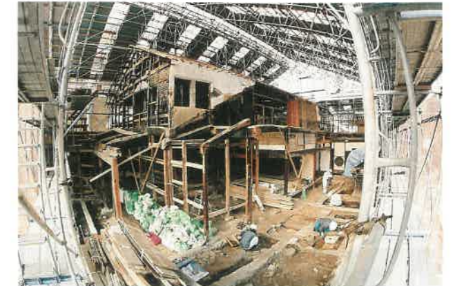
解体工事がほぼ終了した主屋。台所や地下蔵の発掘調査も行いました。
