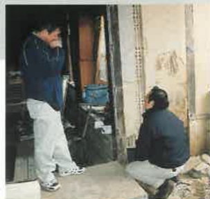
解体途中の痕跡調査。残された柱から式台の痕跡を確認している。
