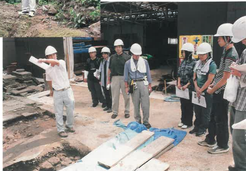
▼町並み最大の民家旧熊谷家で解体修理作業を見学(3日目フィールドワーク)
