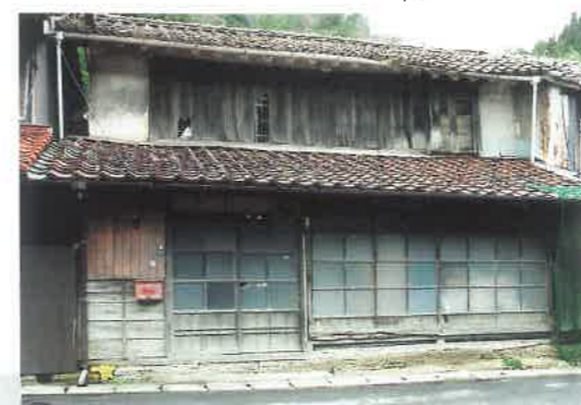
〈修理前 左：旧安田家 右：旧勝部家〉
