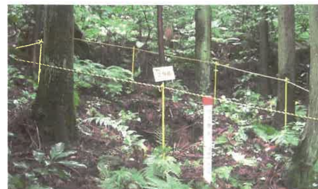
▲立入禁止杭及び危険防止柵の設置状況
