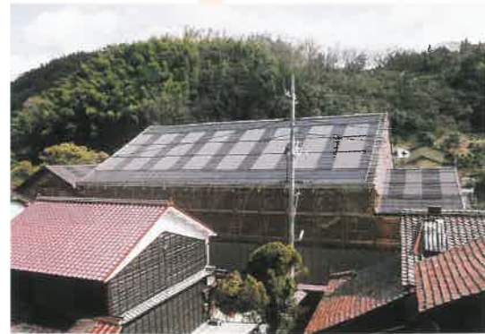
▲平成14年夏 仮設屋根に覆われた主屋
