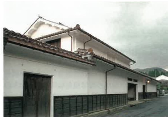
▲平成17年12月 修理が完了した主屋正面外観
