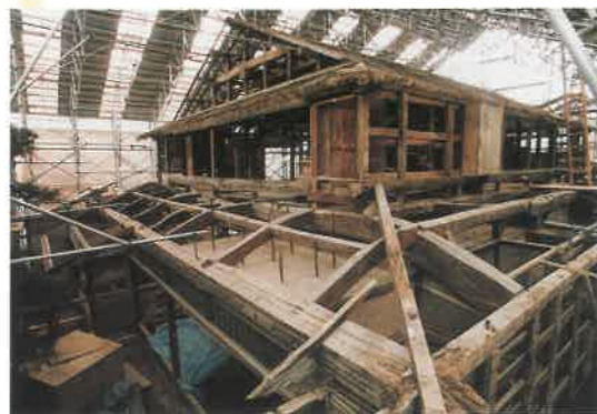
▲平成14年秋 主屋の解体状況
