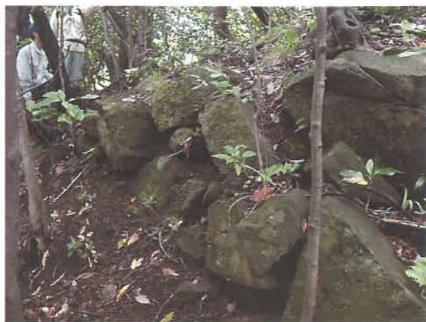
▲石積みの残存状況
