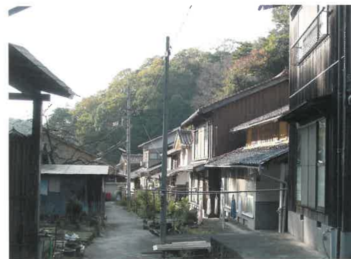
沖泊の集落（水路・街路を挟んで家屋が建ち並ぶ）
