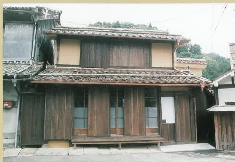
修理後 痕跡に基づき、失われていた雨戸・戸袋を復元し、玄関の間口もかつての幅に復元しました。
