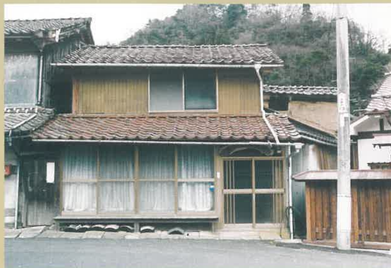
修理前の正面外観（明治中期の創建と推定されます）。
