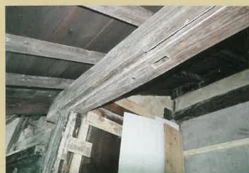
桁に残されていた戸袋の痕跡と一筋鴨居（雨戸のレール）。
