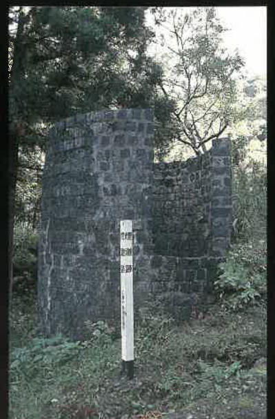
柑子谷の製錬所跡（仁摩町） 街道沿線にはこのような近代的な遺構も残されています。
