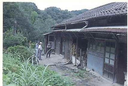
街道沿いの建造物の調査も行います。 仁摩・柑子谷鉱夫住宅
