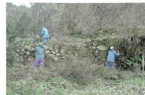
分布調査に入る前、柑子谷地区は山林全体が荒廃し、雑木や竹が生い茂り全く見通しのきかない状況でした。そこで、残存する石垣やテラスの周辺をきれいに伐採しました。
