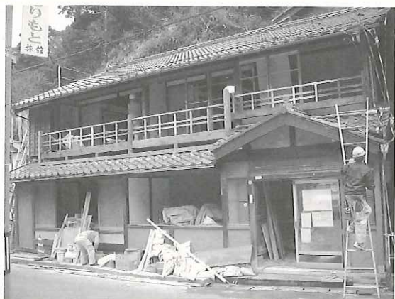
修理中のさわのや旅館
