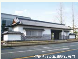
移築された箕浦家武家門
