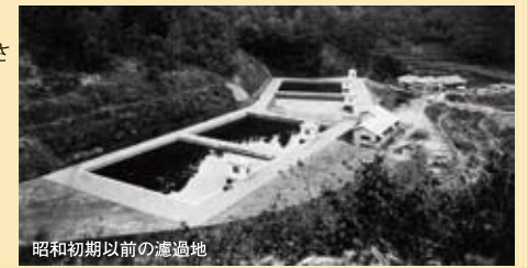
昭和初期以前の濾過池
