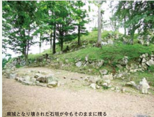
廃城となり壊された石垣が今もそのままに残る
