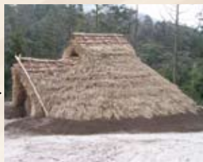
屋根を葺いて完成(妻木晩田遺跡)
