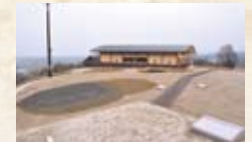
整備された妻木山地区
