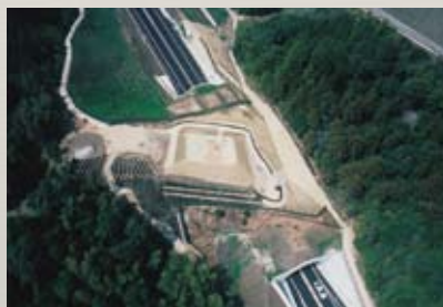
トンネルの上に整備された塩津山1号墳
