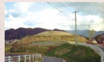
整備後の様子
