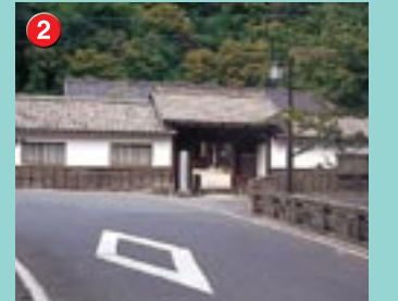
2 大森代官所跡（国指定史跡） 現在は石見銀山資料館となっており、銀山に関するいろいろな展示がしてある。入口の門長屋は江戸時代のもので、門番詰め所や仮牢が現存している。
