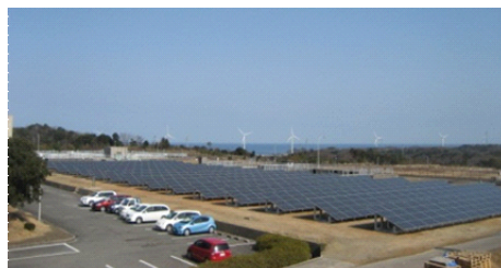
江津浄水場太陽光発電所
