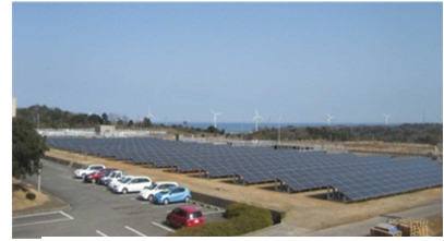
江津浄水場太陽光発電所
