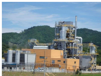
木質バイオマス発電所
