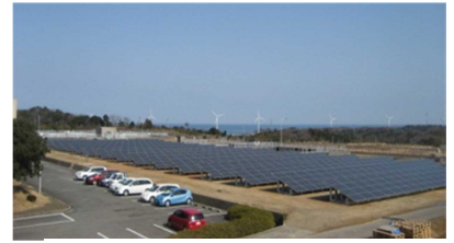
江津浄水場太陽光発電所
