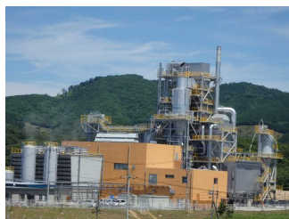
木質バイオマス発電所
