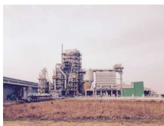
木質バイオマス発電所
