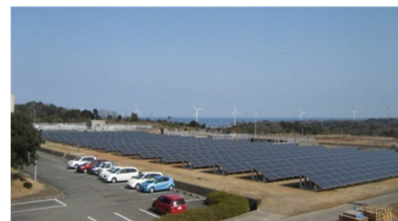
江津浄水場太陽光発電
