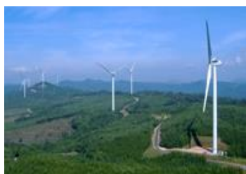
江津高野山風力発電所
