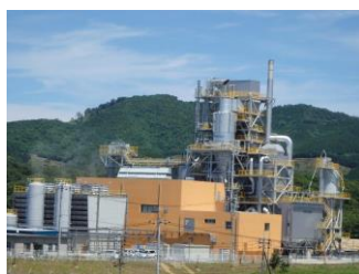
木質バイオマス発電所
