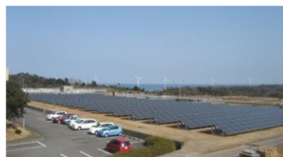
江津浄水場太陽光発電所
