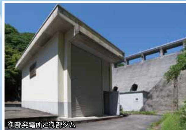
御部発電所と御部ダム
